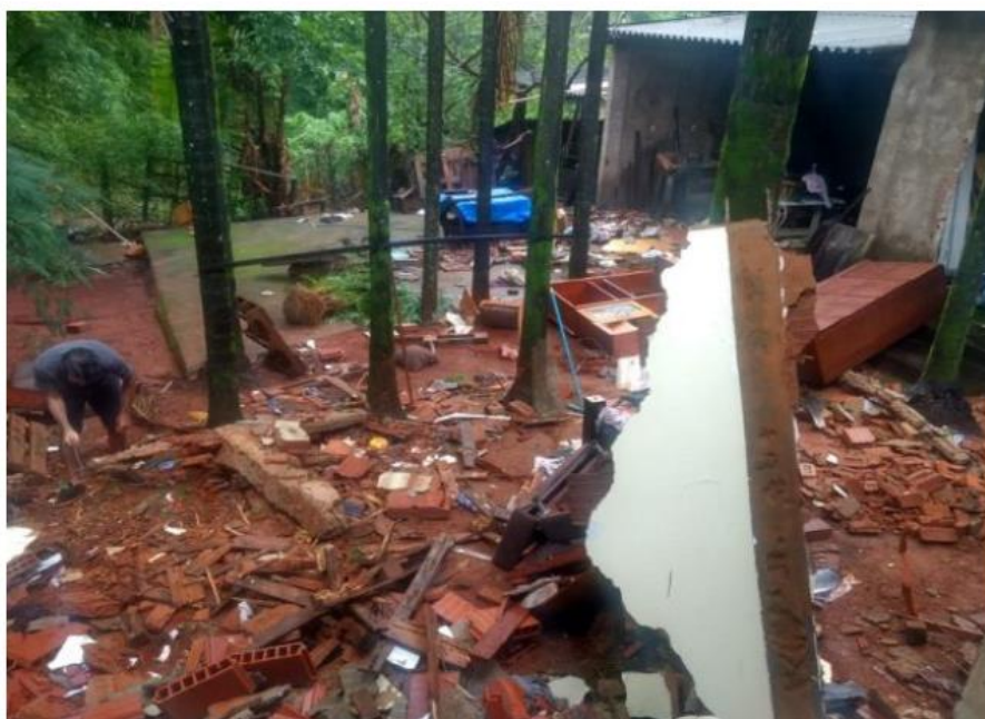
Residência é inundada após chuva em Goiânia (Foto: Defesa Civil/ Divulgação)
