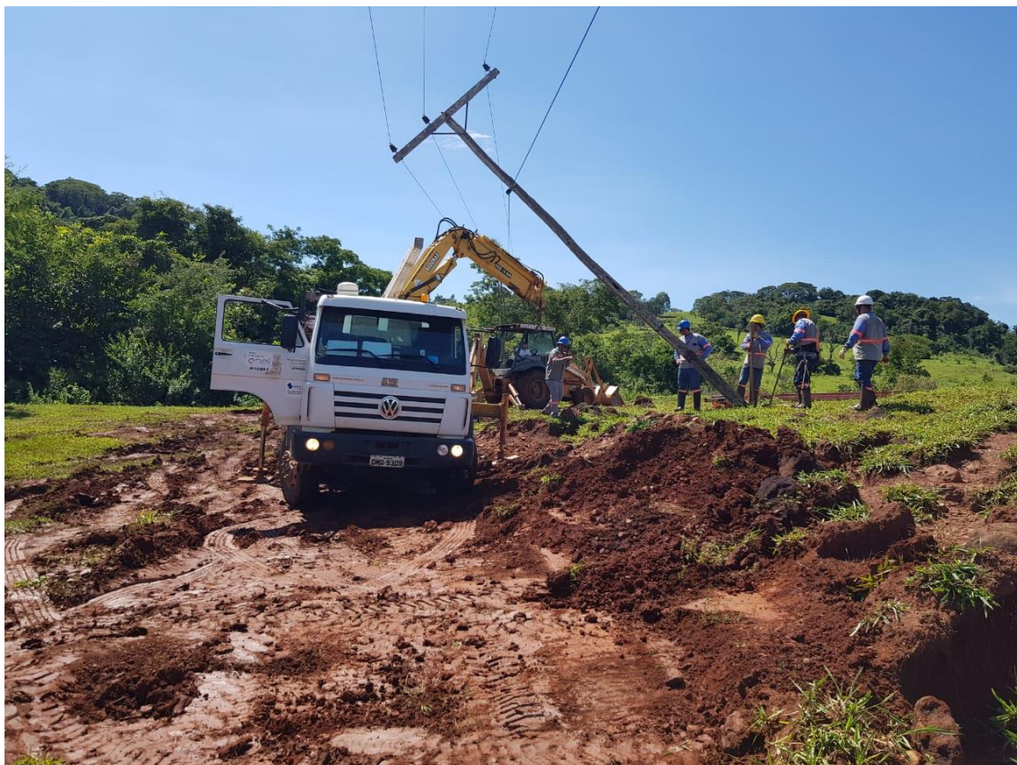
CIRCUITO 02-ANICUNS (09)- OE-210962 EM 10 E 11/03/2019 – FORTE VENTOS E DIFICULDADE DE CAMINHÃO ACESSAR O LOCAL DEVIDO ATOLEIRO.
