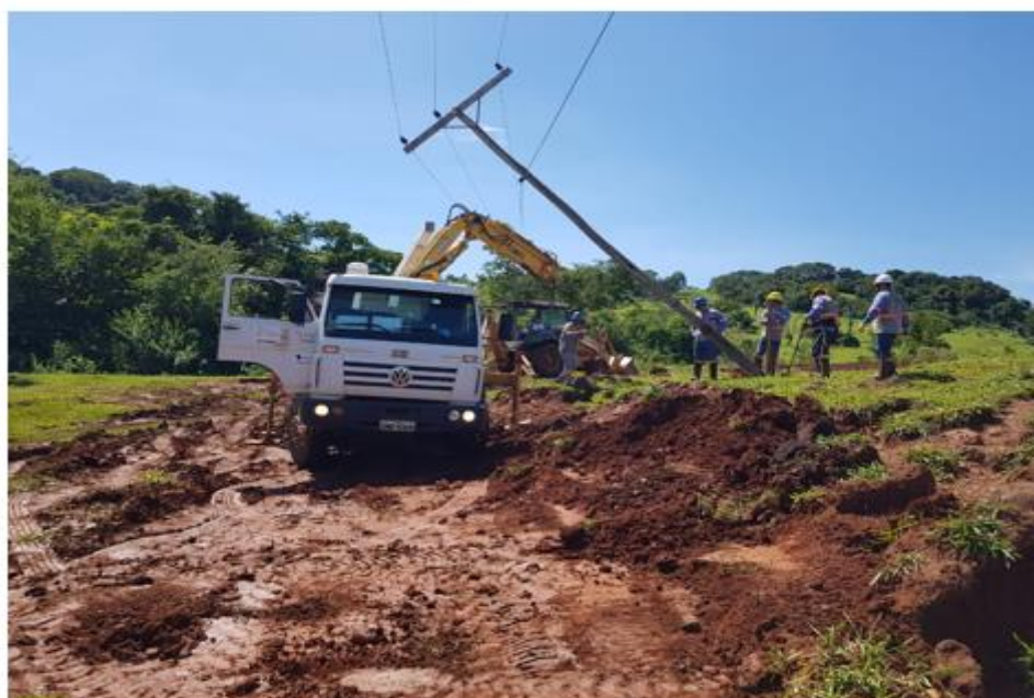
CIRCUITO 02-ANICUNS (09)- OE-210962 EM 06 e 07/03/2019 – FORTE VENTOS E DIFICULDADE DE CAMINHÃO ACESSAR O LOCAL DEVIDO ATOLEIRO.
