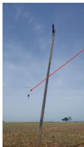
09/11 – OE – 34144 – Cabo Rompido na bucha fase B transformador
