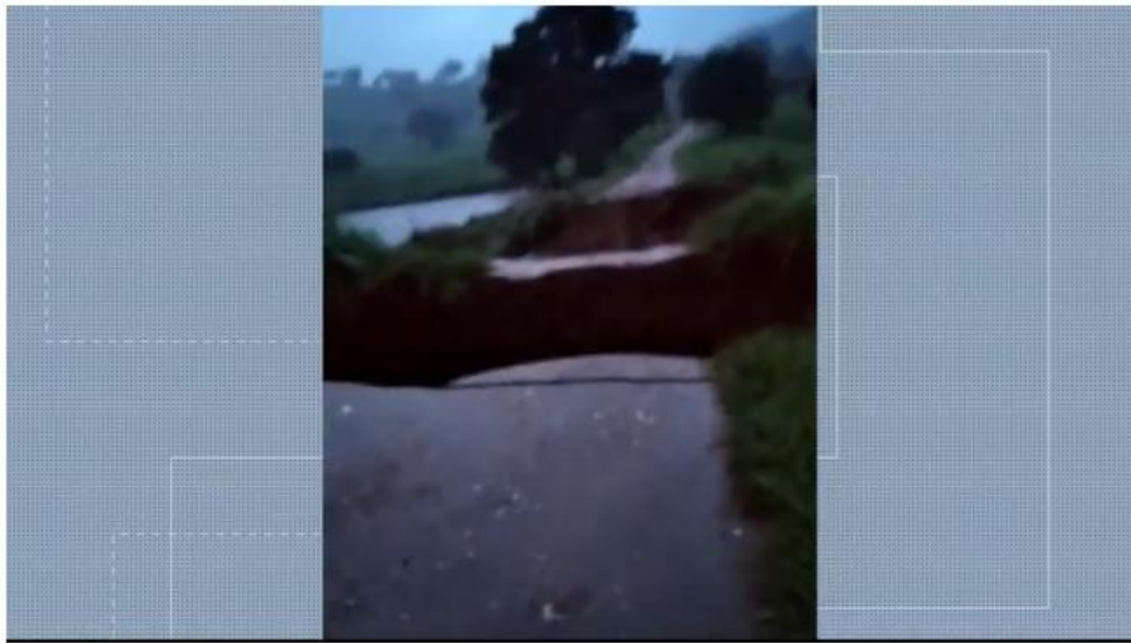
Chuvas fazem rios transbordarem, ponte ser arrastadas e casa ter parede derrubada
