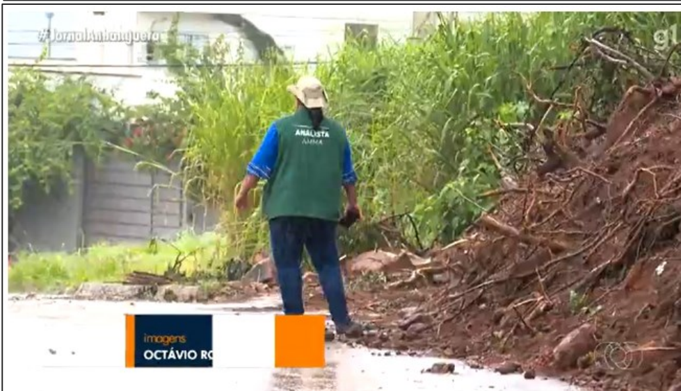
Chuva alaga ruas e suspende trabalho para nivelar área de risco de deslizamento em Goiânia
