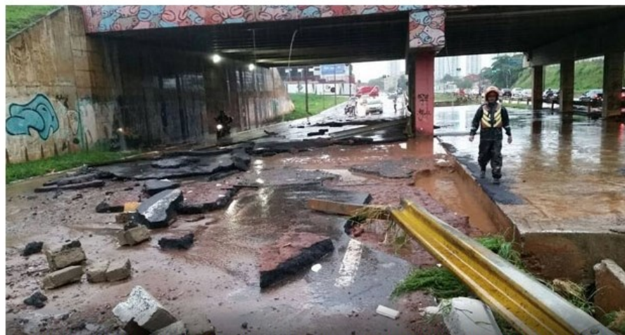
Com desafios de drenagem, Goiânia demanda avanços na prevenção de tragédias ambientais | Foto: Arsênio Neiva
