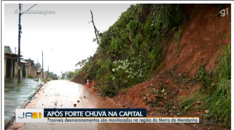
Chuva alaga ruas e suspende trabalho para nivelar área de risco de deslizamento em Goiânia
