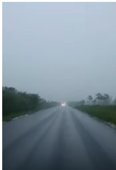
Figura 8. Foto registrada no dia 23/02/24 na localidade Russas.
