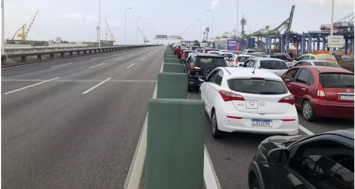
Ponte Rio-Niterói foi interditada devido à ventania, por volta das 14h50 desta terça-feira (21) — Foto: Carlos Brito/G1
