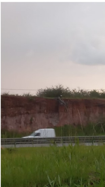
Poste caído no barranco – 16/12/2024 Praia Linda – São Pedro
