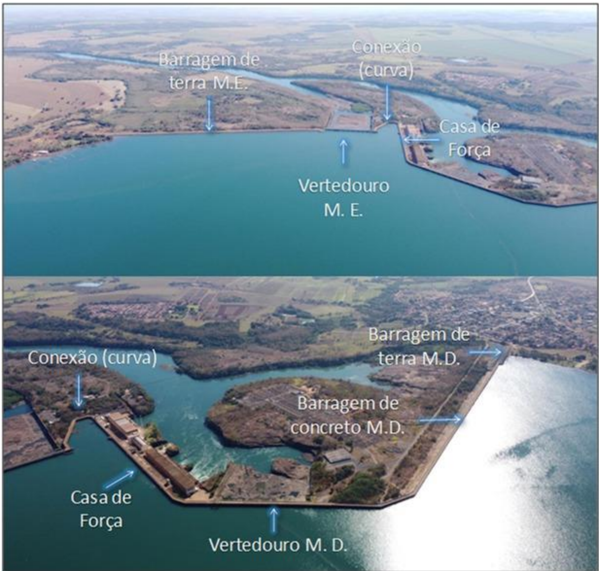
Figura 2 – Arranjo geral da UHE Cachoeira Dourada
